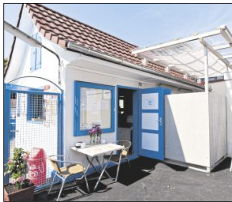
Der Kiosk nach dem Umbau.
